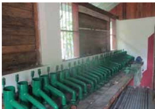
Pompen klaar om te plaatsen
