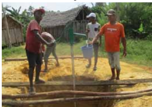
Pomp wordt verder geïnstalleerd
